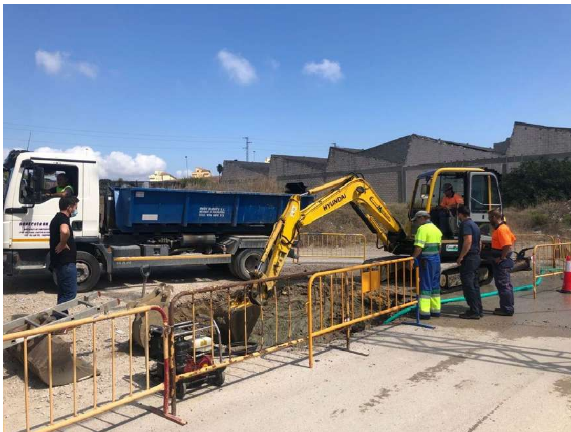
Operarios de Emalgesa reparan una avería en la red de abastecimiento.
